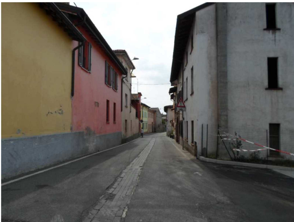
Via XI Febbraio (tratto rimozione cunetta centrale)
